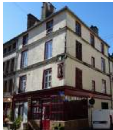
Immeuble avec des bandeaux entre les étages créant des lignes horizontales qui participent à la qualité urbaine des façades – Angle 63, rue nationale et la rue St Maclou
