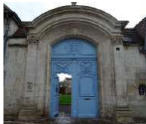
Portail 4, rue St Pierre
