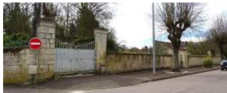
Mur de clôture rue Victor Hugo
