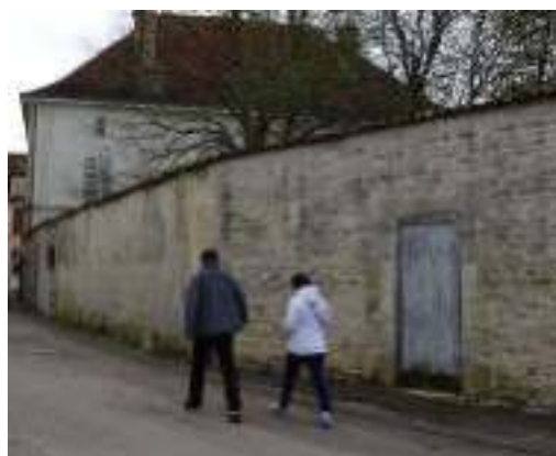
Mur de clôture, rue du Château Gaillard
