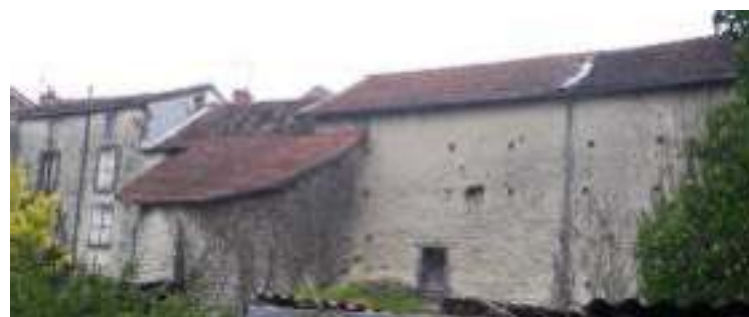
Ancienne tour du rempart situé au 20,22 rue Danton
