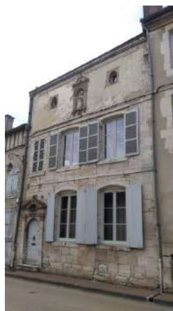
Façade sur rue, 44 rue d'Aube : y compris la menuiserie de la porte d'entrée, et toiture correspondante (IMH : 14 octobre 1963)
