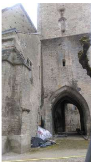
Tour carrée au flanc Nord de l'église Saint-Maclou.
