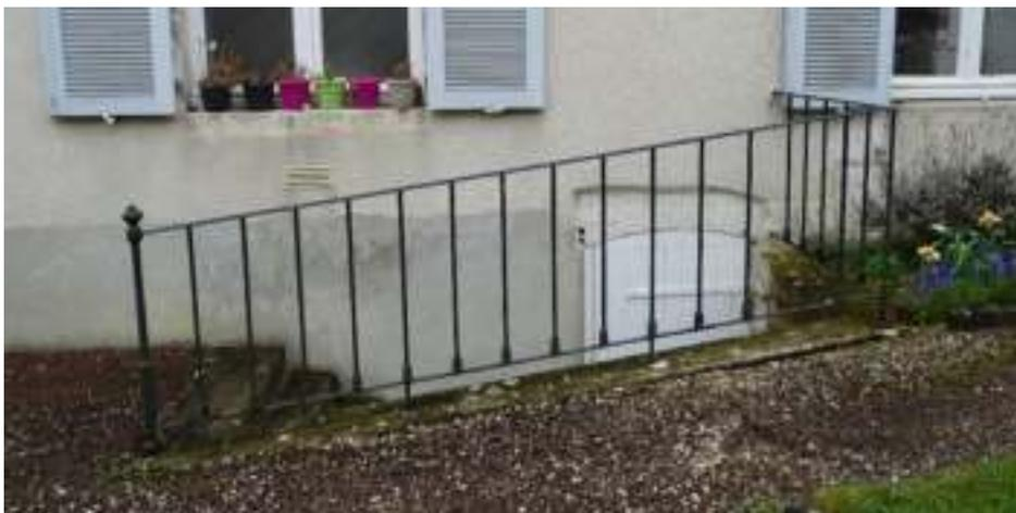
*Garde-corps en serrurerie constitué d'un simple barreaudage en fer rond, orné à la base de bague en fonte – 4, rue St Pierre*
