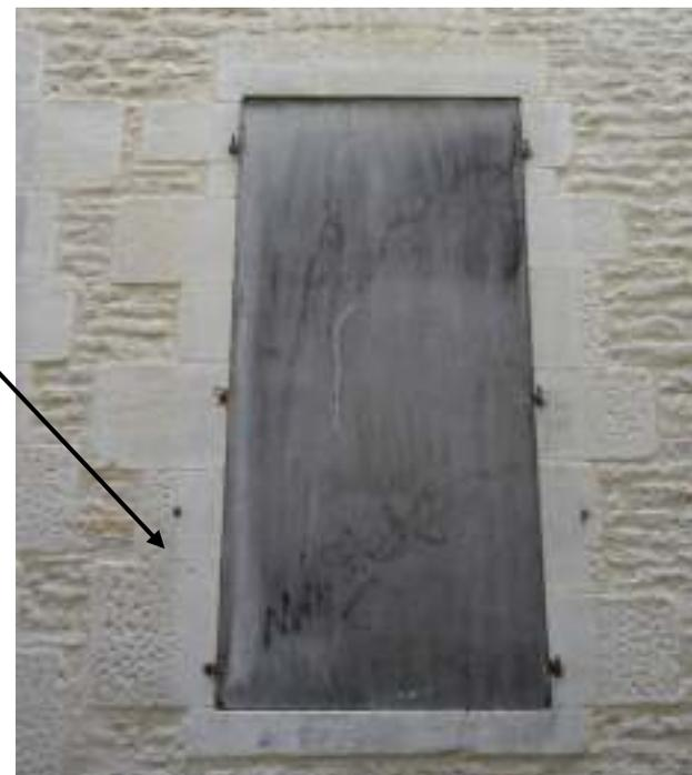
*Façade en maçonnerie de moellons de pierre calcaire. Elle était recouverte d'un enduit délimitant l'encadrement de la baie - 34, rue d'Aube*
