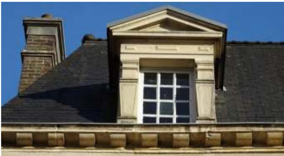
*Lucarne avec un encadrement en pierre de taille surmonté d'un fronton triangulaire - 33, rue d'Aube*
