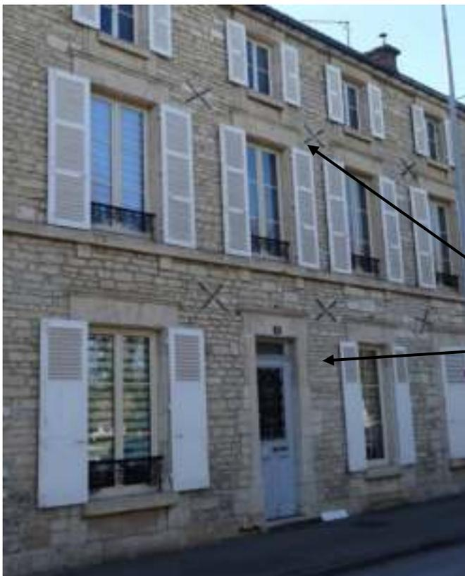
Façade en maçonnerie de moellons de pierre calcaire. Elle était initialement recouverte d'un enduit venant buter sur la moulure d'encadrement de la baie - 1, rue des Anciens combattants
