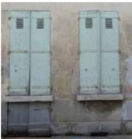
*Volets pleins constitués de planches de bois juxtaposées verticalement et tenues par 3 barres d'assemblage horizontales ou de pentures métalliques - 2, rue de l'Abbé Riel et 4, rue Armand*
