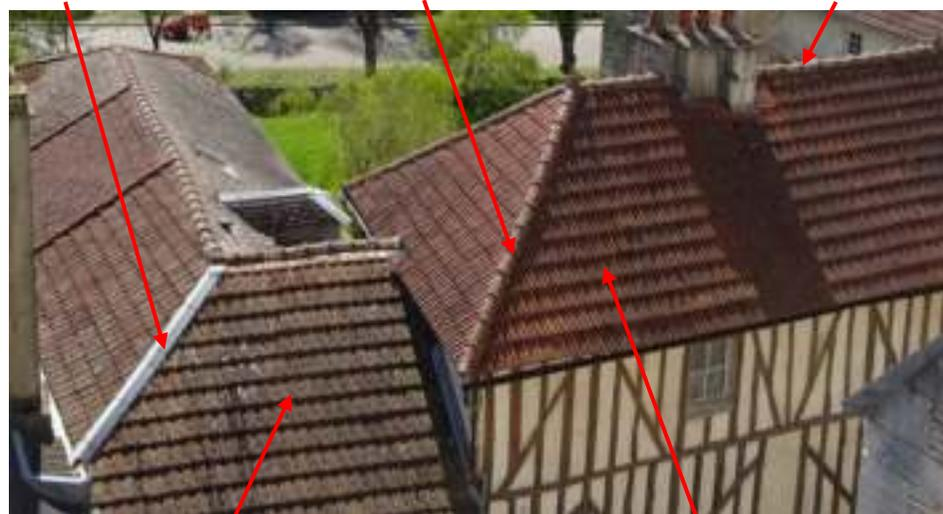
Tuile mécanique losangée brune      tuile mécanique à côte rouge
