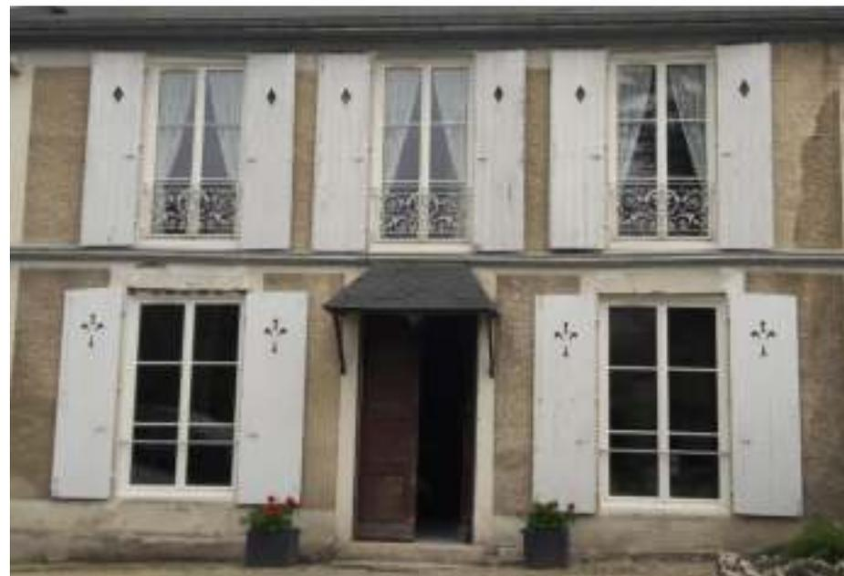
*Volets pleins constitués de planches de bois juxtaposées verticalement et tenues par des barres d'assemblage horizontales ou des pentures métalliques - 6, rue de l'Arquebuse*
