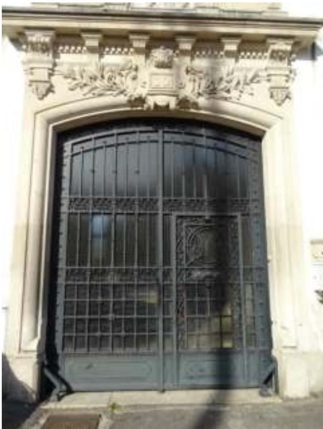
*Porte composée d'une ossature métallique et d'un vitrage doublé de barreaux en fer plein carré - 10, avenue du Général Leclerc*
