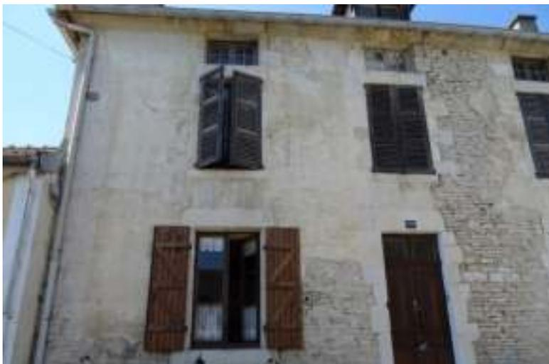
*Façade en maçonnerie de moellons de pierre calcaire et encadrements de baie en pierre de taille - Enduit à la chaux avec une finition talochée – L'enduit est au même nu que les encadrements de baie en pierre de taille - 29, rue Gaston Bachelard*
