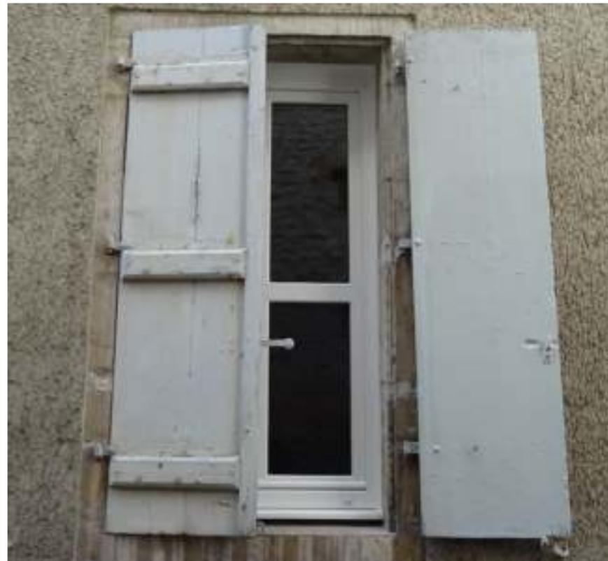
*Volets pleins constitués de planches de bois juxtaposées verticalement et tenues par 3 barres d'assemblage horizontales chanfreinées - 19, rue d'Aube*
