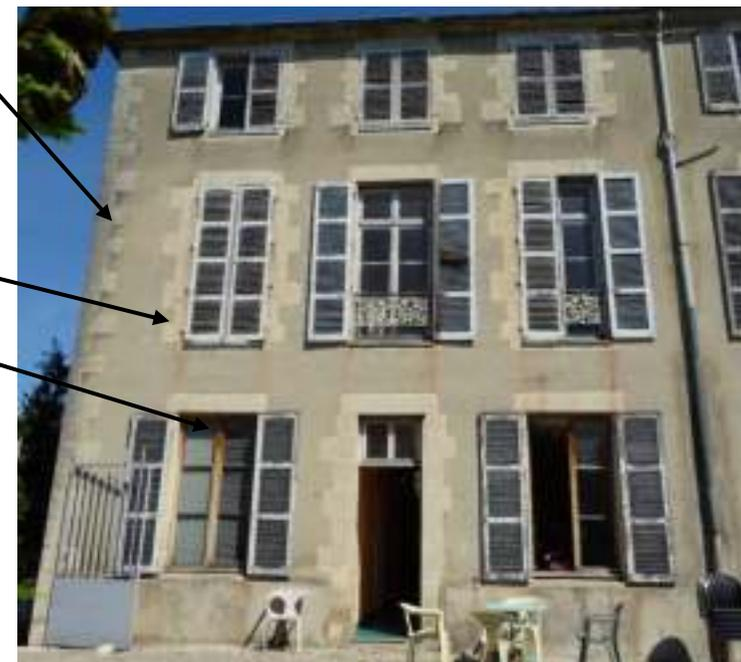
Façade en maçonnerie et encadrements de baie en pierre de taille calcaire - Enduit projeté - L'enduit est au même nu que les encadrements de baie en pierre de taille - 1, rue Gaston Cheq
