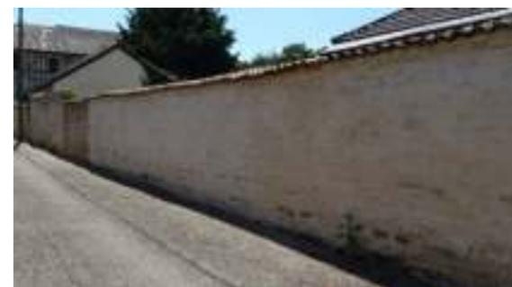
*Mur en maçonnerie avec un parement de moellons de pierre calcaire et un enduit à pierre vue - Le couverture est en tuile canal - 8, rue des Tanneries.*
