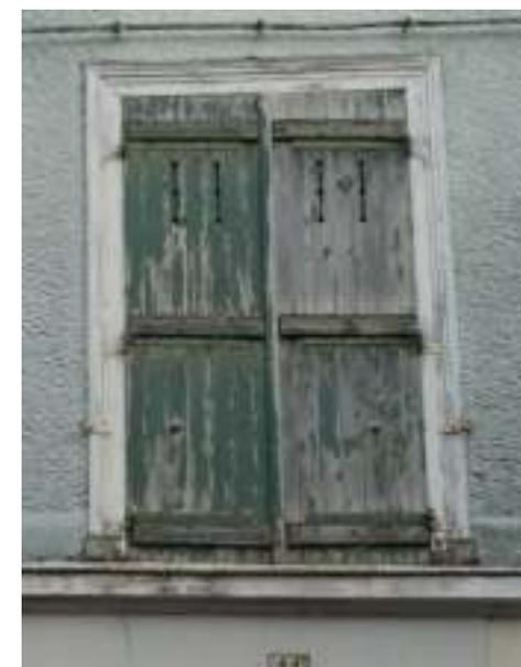
*Façade en pan de bois enduit avec corniche, bandeau et chambranle mouluré encadrant les fenêtres – 11, rue Armand*
