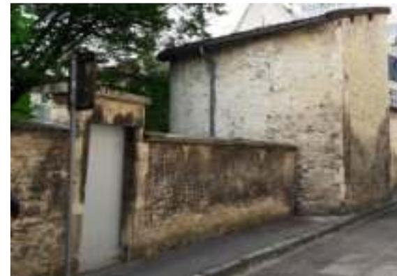
*Mur en maçonnerie avec un parement de moellons de pierre calcaire et encadrement de porte en pierre de taille - Le couverture du mur est en pierre de taille - 2, rue de l'Abbé Riel.*
