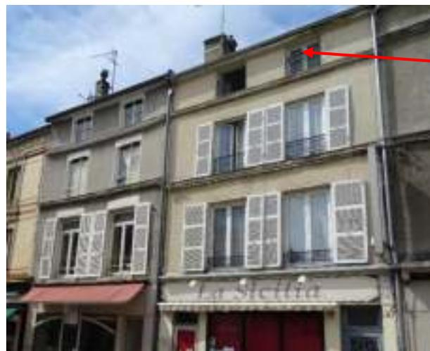
Deuxième étage d'attique avec des fenêtres carrées permettant l'éclairage des combles – 4, rue d'Aube
