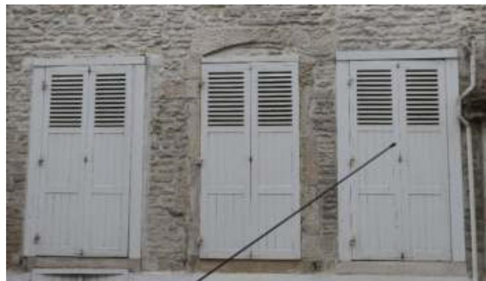
*Volets à battants en bois sur cadre, la partie basse composées de lames assemblées verticalement et la partie haute composées de lames horizontales persiennées - 6, rue St Maclou*
