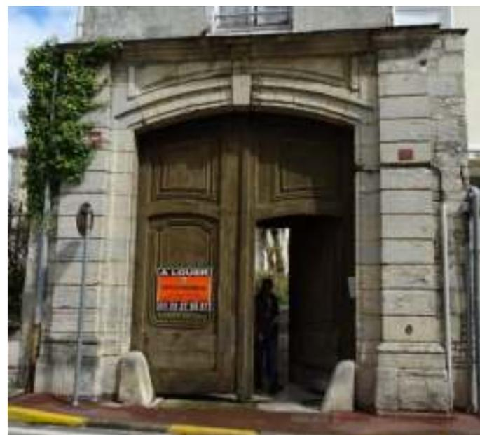
*Portail avec pilastres, linteau segmentaire et corniche moulurée - Porte à deux vantaux à panneaux moulurés - 24, rue du Général Vouillemont*
