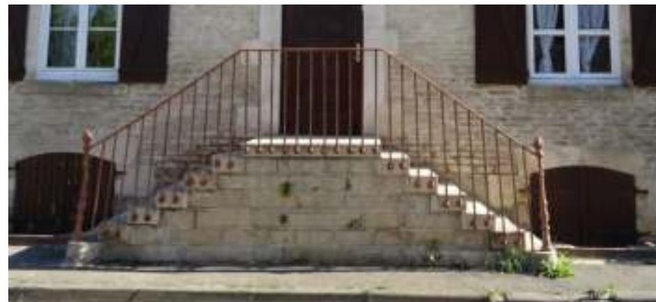
*Garde-corps d'escalier en serrurerie composé d'un simple barreaudage en fer rond, orné à la base de bague en fonte - 25, rue Romagnon*
