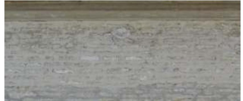
*Enduit « à pierre vue » : le surplus de mortier est raclé à la truelle à fleur de parement pour laisser juste apparaître les arrêtes des pierres les plus saillantes - 29, rue Gaston Bachelard*
