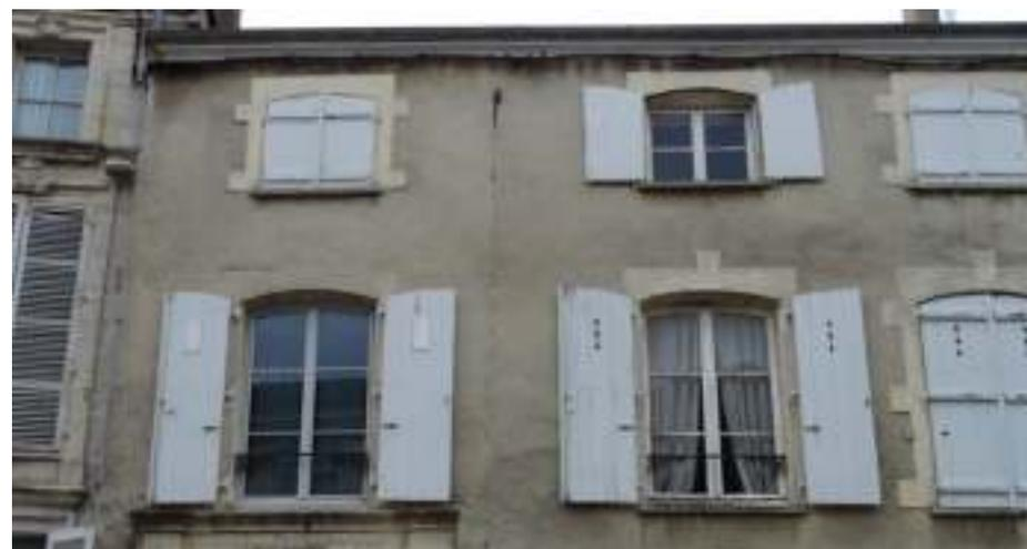
*Volets pleins constitués de planches de bois juxtaposées verticalement et tenues par des barres d'assemblage horizontales - 17, rue d'Aube*
