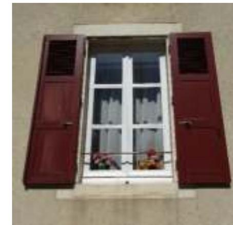
*Volets à battants, en bois sur cadre, la partie basse composée de lames assemblées verticalement et la partie haute composée de lames horizontales persiennées - 10, rue Armand et 30 rue Gambetta*
