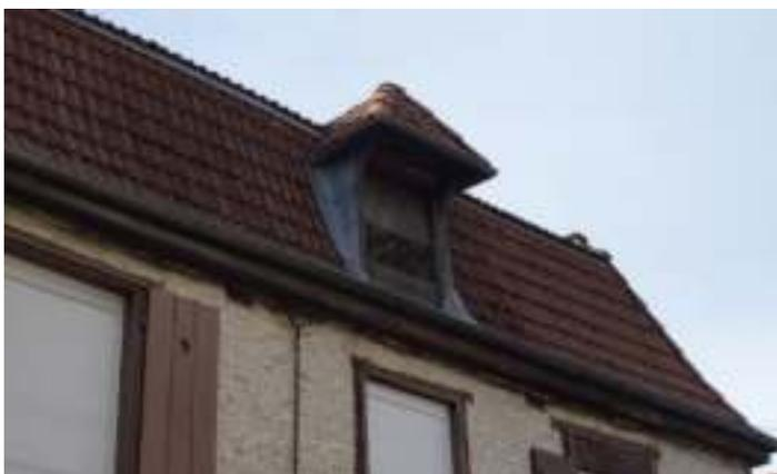
Pan de toiture à la Mansart en tuile mécanique – 14, rue de Mortefontaine
