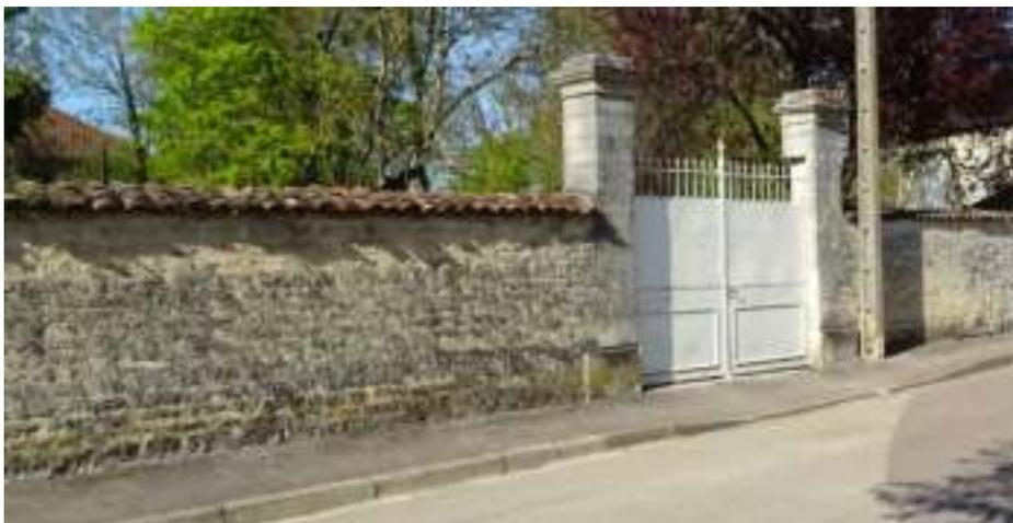
*Murs en maçonnerie avec un parement de moellons de pierre calcaire et un rejointoiement « à fleur » - La porte est encadrée par des piliers en pierre de taille - Le couverture du mur est en tuile canal - 3, rue de Puisant.*
