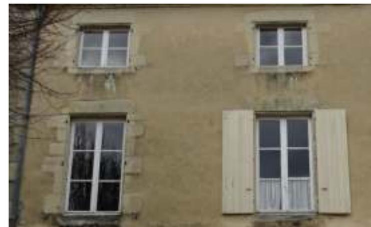
Façade en maçonnerie et encadrements de baie en pierre de taille calcaire - Enduit à la chaux mince finition talochée fin - 9, rue du collèèg
