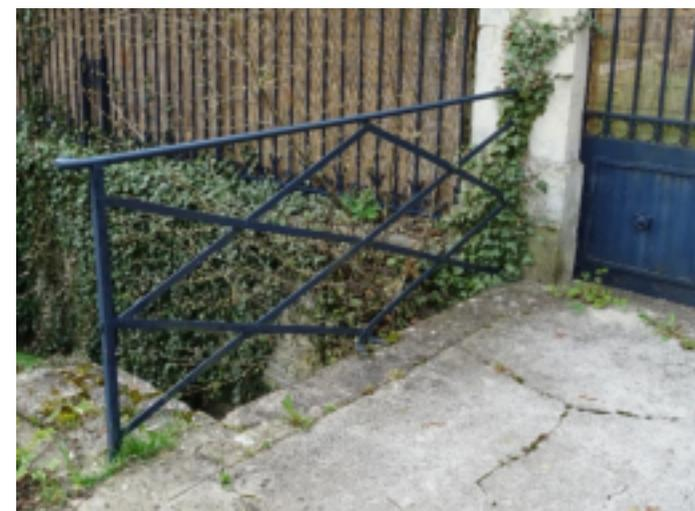
*Passerelles et portes composées de piliers en pierre de taille et de portails en ferronnerie – Garde-corps en ferronnerie composés de croix de St André*
