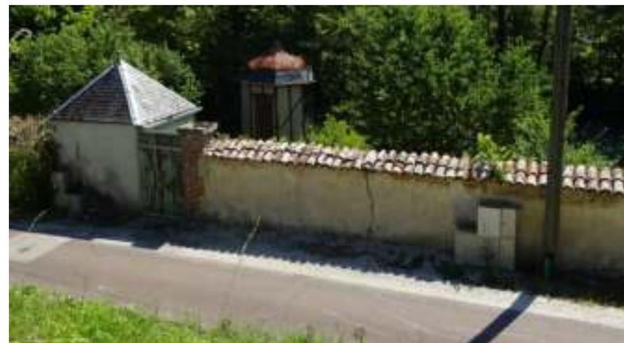
*Murs en maçonnerie recouvert d'un enduit taloché- Le couverture du mur est en tuile canal - chemin rural de Bar-sur-Aube à Fontaine.*
