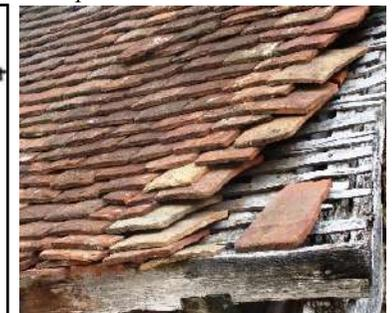
Mise en œuvre de la petite tuile plate sur chevrons et lattes
