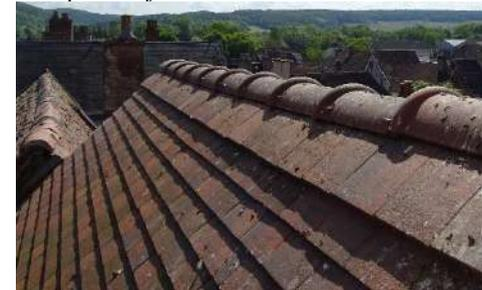
Tuiles faitières à recouvrement par un bourrelet
