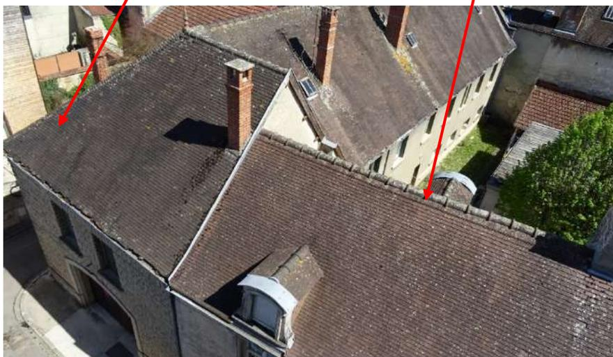
Exemple de toiture en petites tuiles plates, à 4 pans
