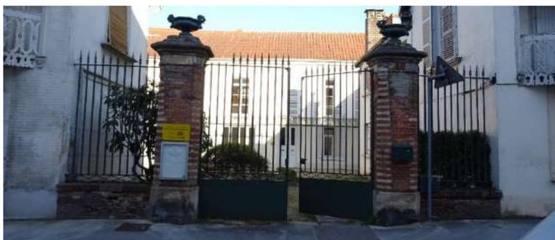
(7) Exemple de grille en serrurerie sur un mur bahut en maçonnerie avec de piliers en brique et pierre
