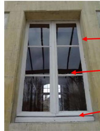
Les fenêtres sont en bois dur. Le dormant est pris dans la maçonnerie et n'est visible que d'un à deux cm, pour gagner de la lumière.
