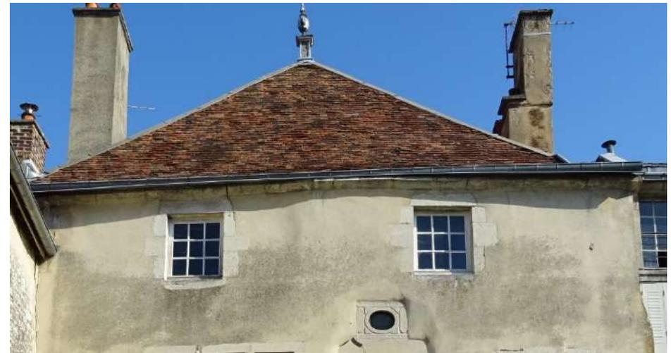
*Exemple de toiture en petites tuiles plates, à 4 pans – 14, rue d'Aube*
