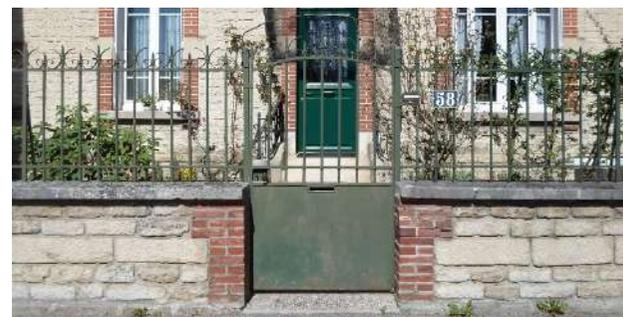
(6) Exemple de clôture composé d'un mur bahut en maçonnerie de pierre de taille, surmonté d'une grille en ferronnerie - 58, Bd Gambetta
