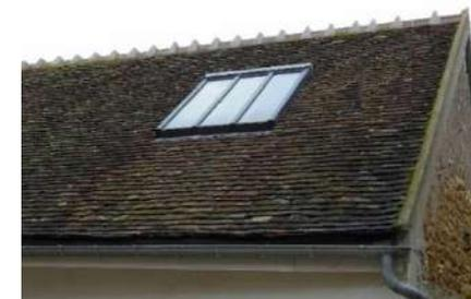
Exemple de châssis de toit métalliques, de type patrimoine, avec un meneau central assimilé aux anciennes tabatières et verrière de toit.
