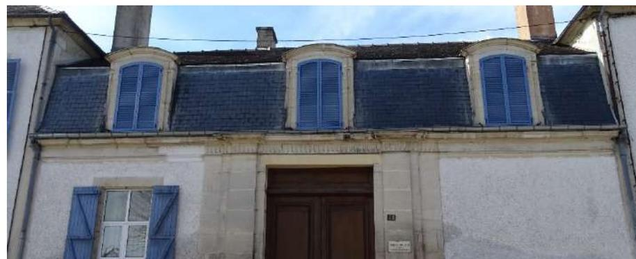
Exemple de toiture à pan brisé avec la partie supérieure couverte en petites tuiles plates et partie inférieure à la « Mansart » couverte en ardoise - 32, boulevard Victor Hugo
