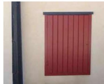
(8) Exemple de coffret technique encastré et fermé par un portillon constitué de lames de bois verticales assemblées.
