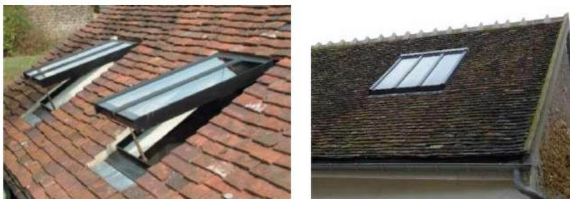
Exemple de châssis de toit métalliques, de type patrimoine, avec un meneau central assimilé aux anciennes tabatières et verrière de toit.
