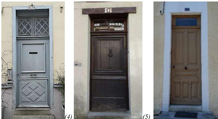
Portes à un battant en bois à panneaux d'assemblage et à imposte vitrée
