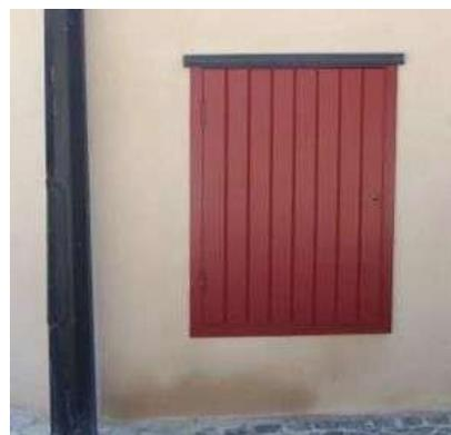
(8) Exemple de coffret technique encastré et fermé par un portillon constitué de lames de bois verticales assemblées.
