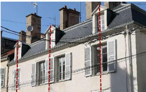
(3) Lucarnes charpentées à deux pans, axées sur les fenêtres ou les meneaux
