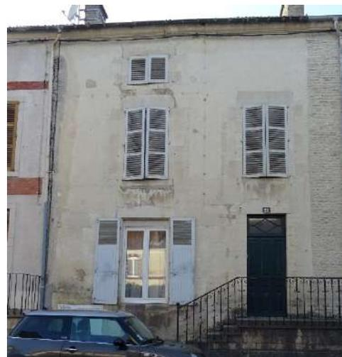
(6) Exemple de façade en maçonnerie de moellons de pierre calcaire et encadrements de baie en pierre de taille - Enduit à la chaux avec une finition talochée - L'enduit est au même nu que les encadrements de baie en pierre de taille - 31, rue du Général de Gaulle
