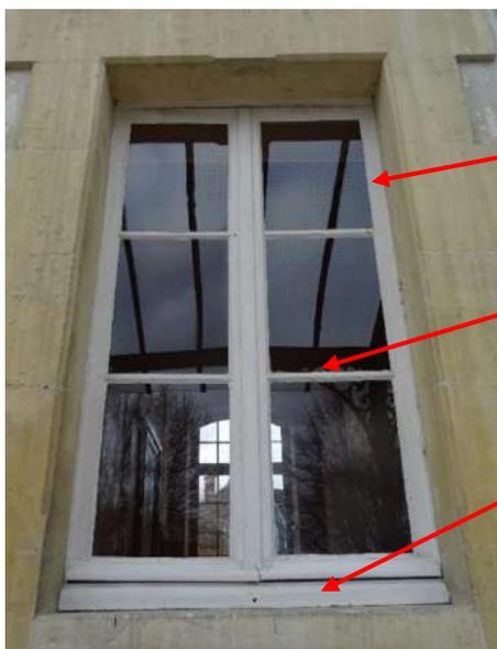
*Les fenêtres sont en bois dur. Le dormant est pris dans la maçonnerie et n'est visible que d'un à deux cm, pour gagner de la lumière.*
