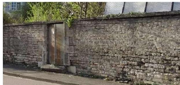
(3) Exemple de mur en maçonnerie de moellons de pierre calcaire et un rejointoyement « à fleur » - Le couvrement est en pierre de taille - Bd de la République.
