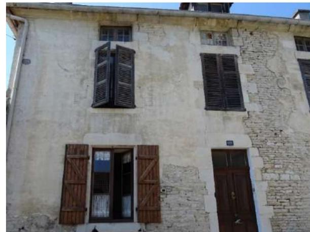
(6) Exemple de façade en maçonnerie de moellons de pierre calcaire et encadrements de baie en pierre de taille - Enduit à la chaux avec une finition talochée - L'enduit est au même nu que les encadrements de baie en pierre de taille - 29, rue Gaston Bachelard
