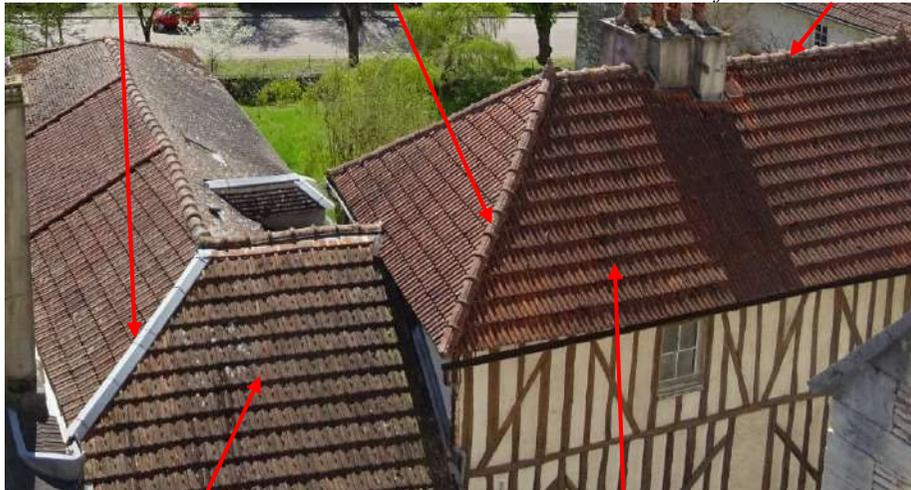
Tuile mécanique losangée brune    tuile mécanique à côté rouge
