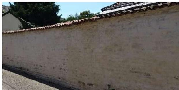
(4) Exemple de mur en maçonnerie avec un parement de moellons de pierre calcaire et un enduit à pierre vue - Le couvrement est en tuile canal – 8, rue des Tanneries.
