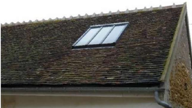
*Exemple de verrière avec un cadre métallique et des meneaux verticaux*
