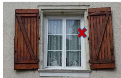
(8) Exemple de fenêtres en PVC interdites et de volets en bois lasuré avec des écharpes interdites
