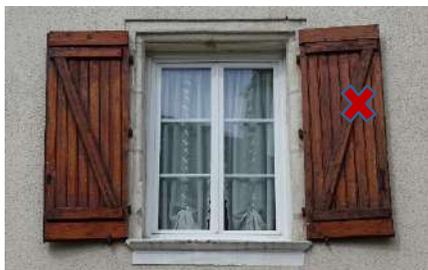
(8) Exemple de volets en bois lasuré avec des écharpes interdites
