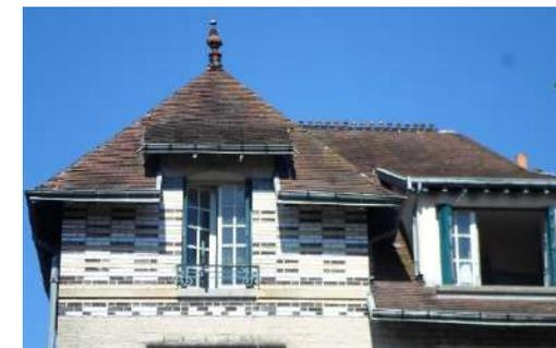
Tuiles faitières à recouvrement par un bourrelet et toiture en petites tuiles plates- 52, Bd Gambetta,
