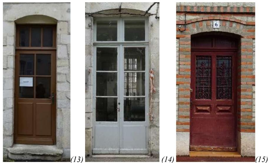
Porte en bois à panneaux d'assemblage, la partie supérieure vitrée - (13) 4, rue St Pierre- (14) 15, rue Armand - (15) Porte en bois à panneaux, la partie supérieure vitrée protégée par une grille de défense -6, rue du G<sup>al</sup> de Vouillemont
