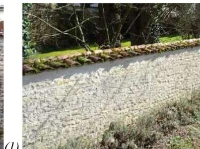
Exemple de mur de clôture en maçonnerie de moellons de pierre calcaire avec un rejointoyement des joints "à fleur" et protégé par une couvertine en tuile canal – (1)12, rue du Collège – (2) Bd Gambetta
