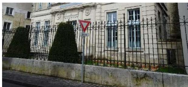
(6) Exemple de clôture composé d'un mur bahut en maçonnerie de pierre de taille, surmonté d'une grille en ferronnerie - 24, rue St Pierre
